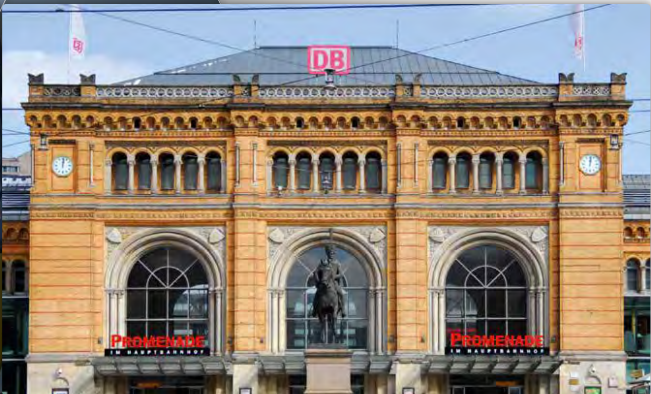
Hannover Hauptbahnhof | © Deutsche Bahn AG | Foto: Christian Bedeschinski
