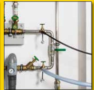
Druckprüfung mit Wasser (SLW)
