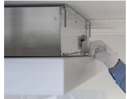
Abbildung 3: Lösen der Mutter (M8).
