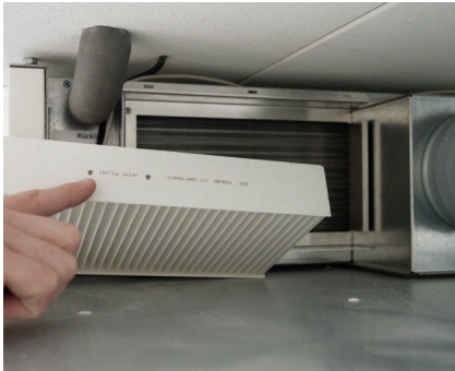
Abbildung 1: Einsetzen der Filterzelle (als Ersatzteil erhältlich)
