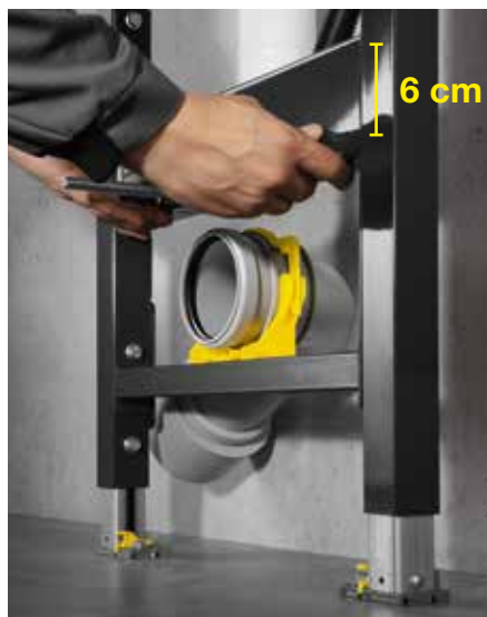
Im Handumdrehen realisierbar: die serienmäßige Höhenverstellung um 6 cm
