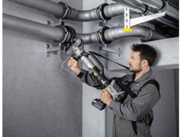
Das Megapress S-Pressverbindersystem bietet mit den Dimensionen bis 2 Zoll eine optimale Anbindungsmöglichkeit (nach AGFW FW 524) an Nah- und Fernwärmenetze. Ab dem Gebäudeeintritt können die dort häufig eingesetzten dickwandigen Stahlrohre schnell und sicher verpresst werden.
