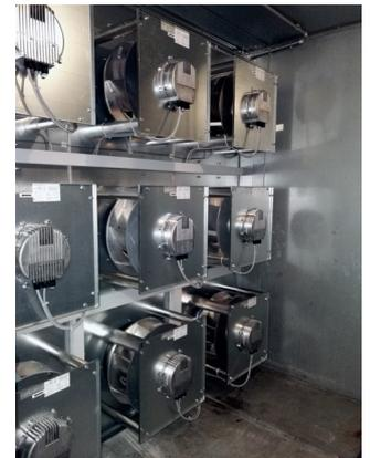
Abb. 11) Druckseite der ECFanGrid
