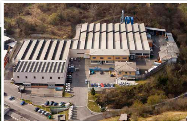
Stabilimento per valvole industriali 7.000 m 2
