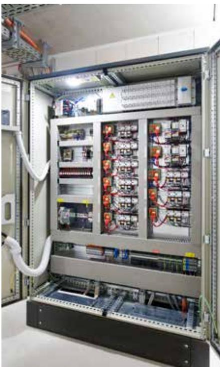
Das Systemair-Regelsystem umfasst die Steuerung von Ventilatoren für die Lüftung und Entrauchung von Tiefgaragen.
