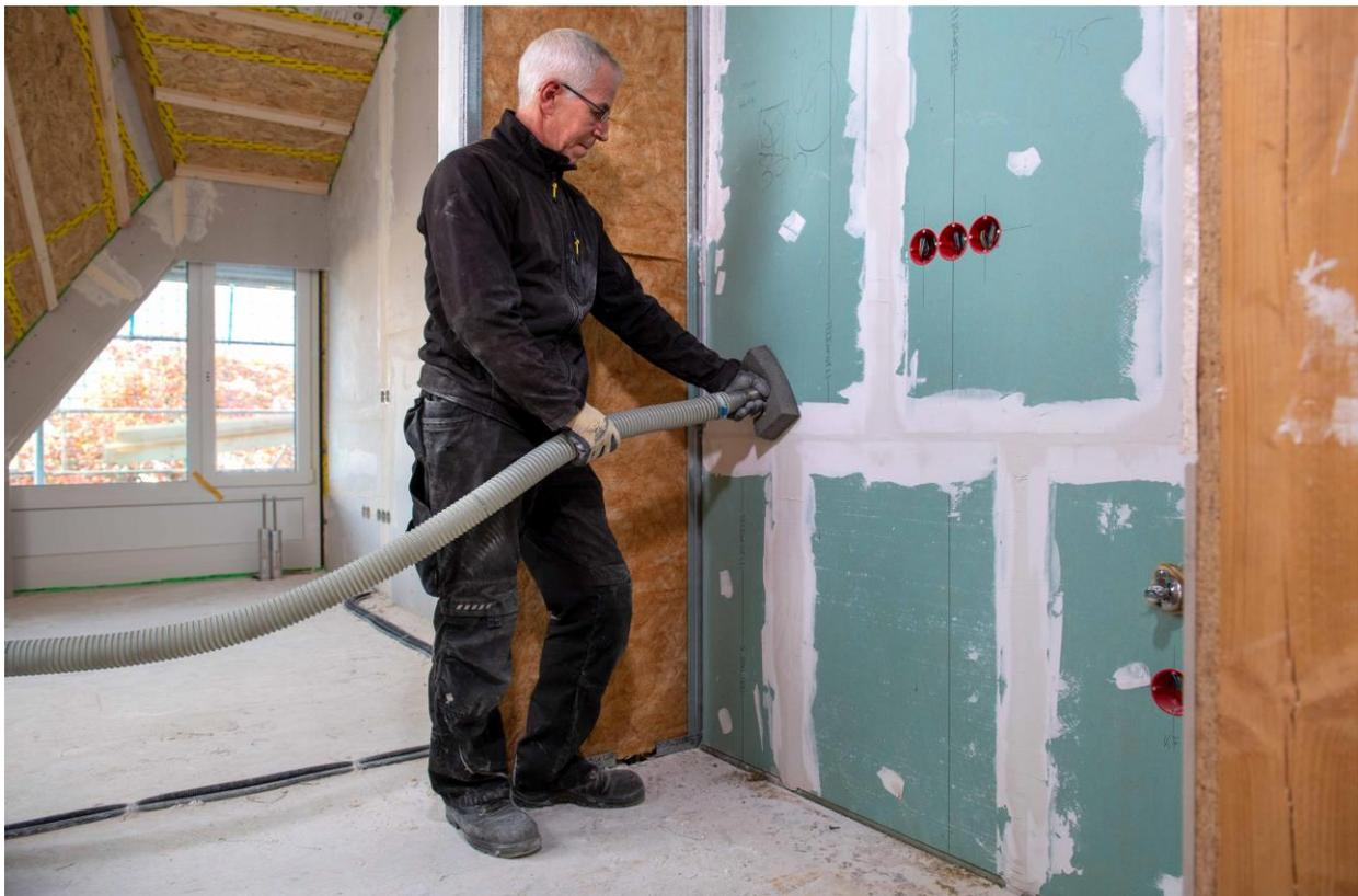
Auf der Baustelle wird die Installationswand gemäß allgemeiner Bauartgenehmigung (aBG), beplankt und mit einer mineralischen Einblasdämmung hohlraumfrei verfüllt.
