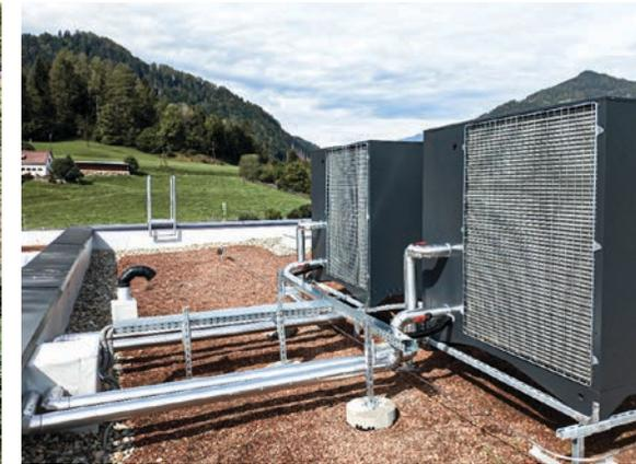
**Findet sich im Gebäude kein Platz für die Unterbringung, ist dies kein Problem mehr:** OLYMP OlyJet Wärmepumpen sind perfekt gerüstet für die Außenaufstellung. Das robuste sowie korrosionsbeständige Gehäuse sorgt für optimalen Schutz vor Witterung, lässt sich einfach reinigen und behält auch über die Jahre seine perfekte Oberflächenoptik.
