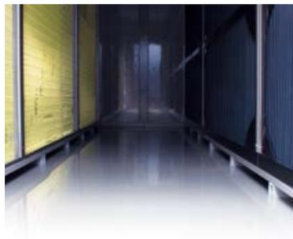
Die Tropfschale unter dem Kühler ist vollständig zugänglich und leicht zu reinigen.
