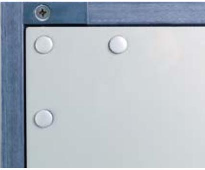
Elementwand ist witterungs- und UV-beständig, bestehend aus einer Verbundrahmenkonstruktion und Verbundplatten mit Gelcoat-Deckschicht.
