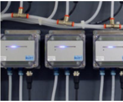
Das Klimagerät kann mit einem sogenannten -BaOpt™ -Steuerungssystem geliefert werden, um eine homogenere Luftkondition im Schwimmbad zu erreichen. Mit diesem Steuersystem werden zusätzliche thermische und elektrische Energieeinsparungen erzielt.
