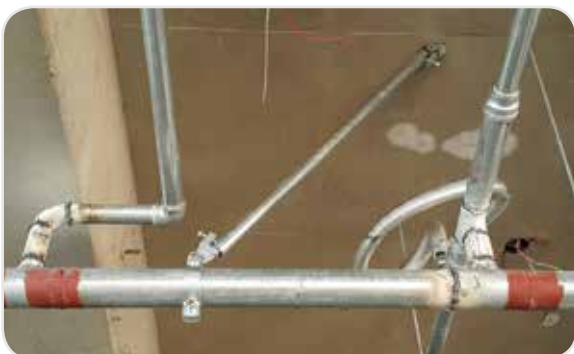
● Longitudinal Sway Bracing
