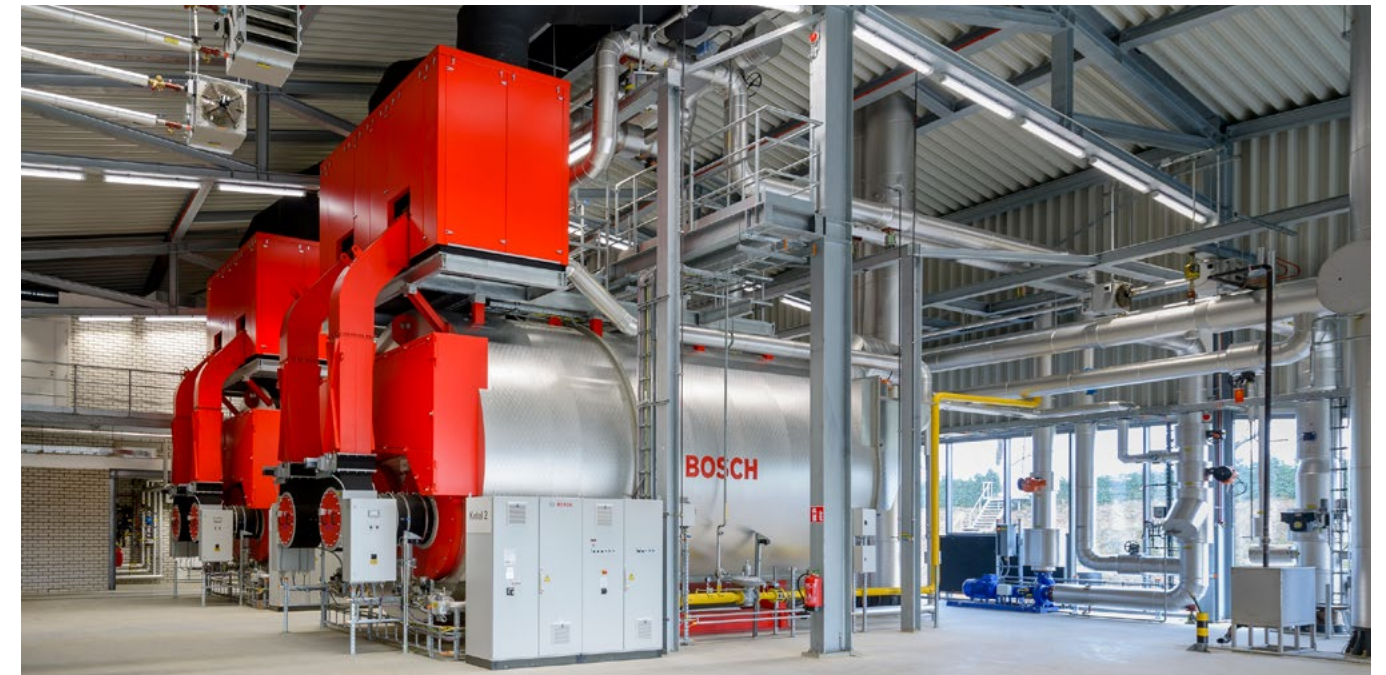
Bei der kundenspezifischen Kesselanlage im Heizkraftwerk Pieter Wiersma liegen die NO x -Werte unter 50 mg/Nm 3 .
