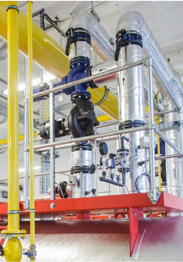
Rücklauftemperatur-Absicherung RTS
