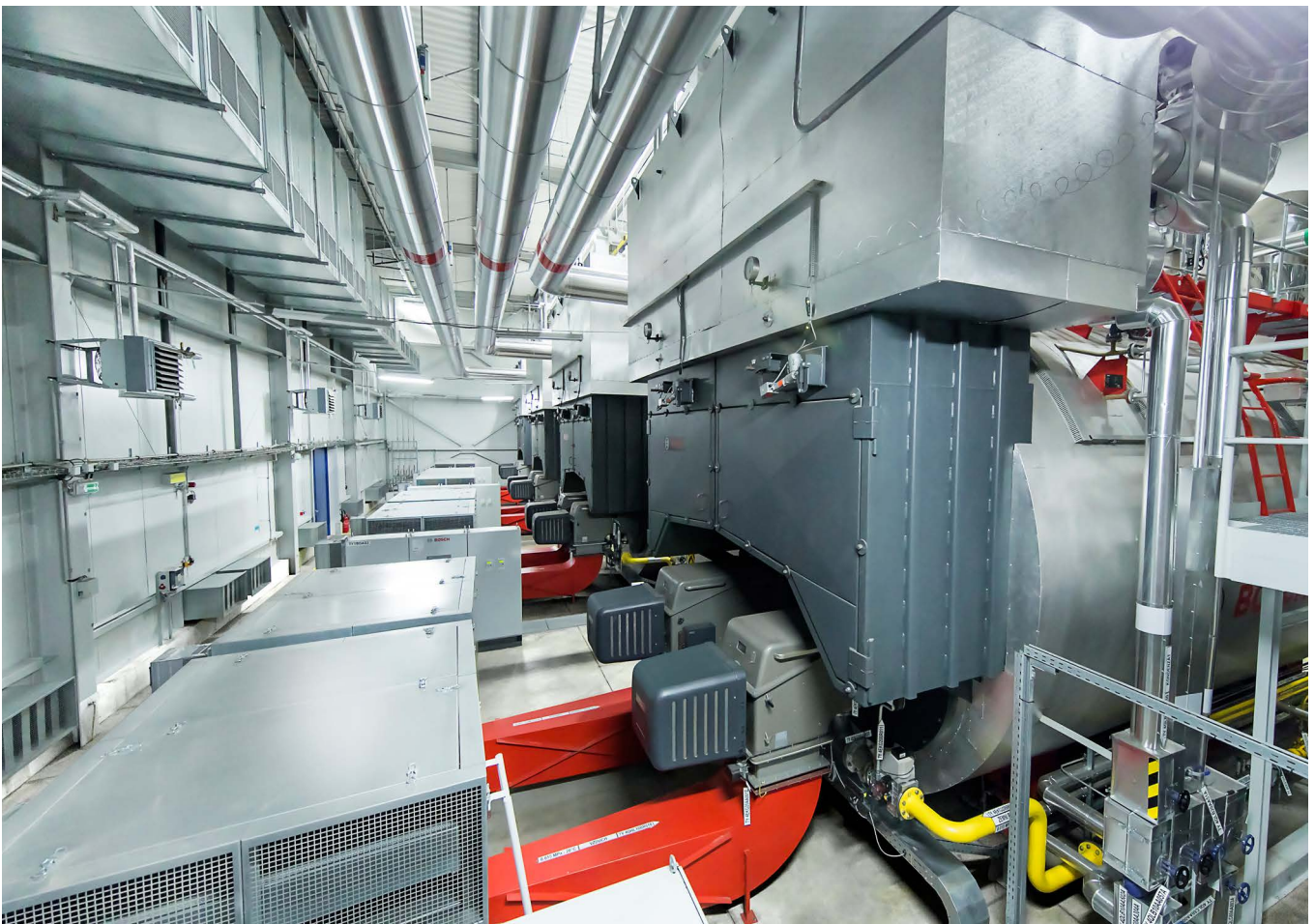
Die Überhitzermodule sind auf der vorderen Wendekammer der Kessel aufgesetzt.
