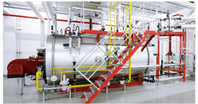
Der neue, hocheffiziente Dampfkessel UL-S mit Erdgasfeuerung und Einrichtungen zur Wärmerückgewinnung.
