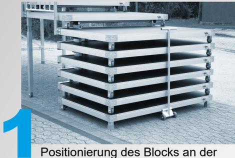
**1** Positionierung des Blocks an der gewünschten Stelle. Auf Wunsch ausgerüstet mit pneumatisch versenkbaren Transportrollen.
