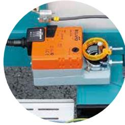
Zuluftklappe mit Stellmotor
