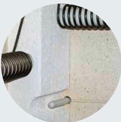
Thermoelement, geschützt eingebaut
